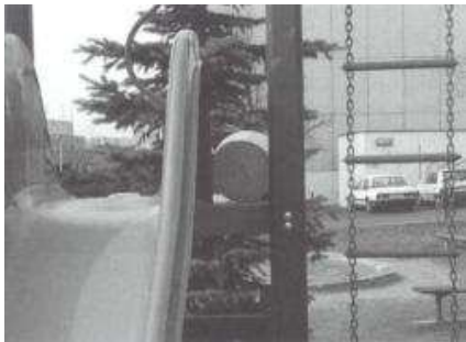
Nebezpečný volný prostor mezi startovní částí skluzavky a stojinou herního prvku - zkušební prostředek otvorem neprošel, hrozí nebezpečí zachycení hlavy dítěte
