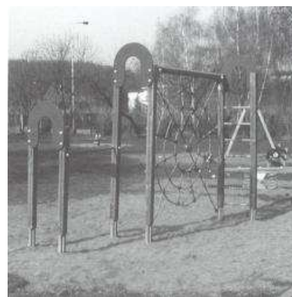
Skuzavka a houpačka vyhovující technickým požadavkům a ve všech směrech vyhovující víceúčelové zařízení (hrazdička, lezecká provazová stěna, žebřina), má i dopadovou plochu z písku
