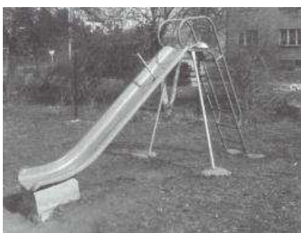
Chybně provedená montáž do betonových bloků, které vyčnívají, není ošetřena dopadová plocha
