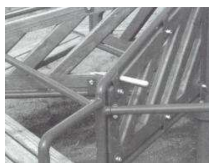
Kolotoč má nepřijatelné otvory - nebezpečí zachycení prstu
