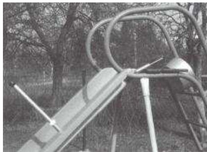
Nevyhovující výška postranic skluzu, výška madel, vzdálenost mezi příčlemi (nebezpečí zachycení hlavy), nevyhovuje startovací část (nebezpečí zachycení prstů), otvory a škvíry mezi skluzem a sedátkem (nebezpečí zachycení ošacení - šňůrky od rukávů, bund a kapucí)
