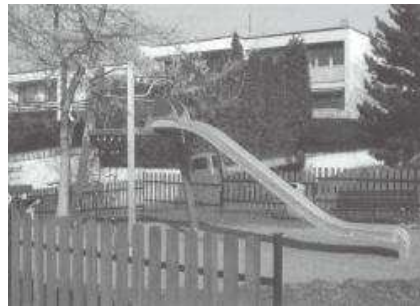
Víceúčelová sestava vyhovující ve všech směrech, provedena dopadová plocha z písku a také vyhovující víceúčelové zařízení se skluzavkou
